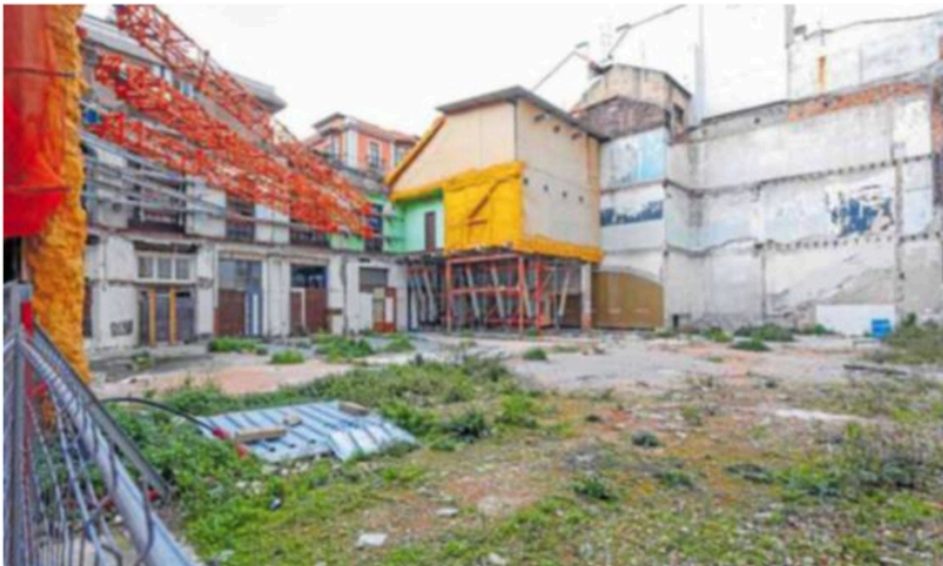
Estado actual del solar entre las calles San Bernardo y Emilio Villa tras el arriostramiento de la fachada del palacete de Manuel del Busto. ARNALDO GARCÍA
